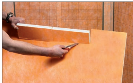
11 Gefälleboard entsprechend der Rinnengröße mit einem Cuttermesser gemäß rückseitiger Schnittmarkierungen ausklinken.
