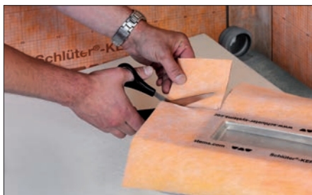
1 KERDI Manschette für den Eckbereich zuschneiden.
