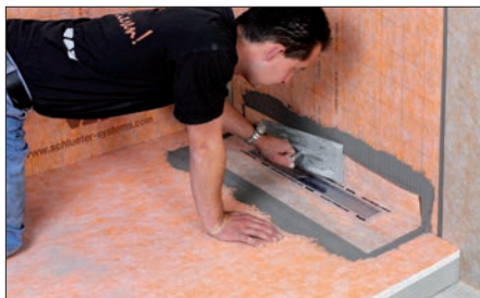
13 Schlüter-KERDI Manschette mit KERDI-COLL-L verkleben. Wand- und Bodenanschlüsse sind mit KERDI-KEBA ebenfalls mit KERDI-COLL-L dicht zu verkleben.
