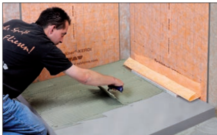
10 Dünnbettmörtel auf ausreichend tragfähiger Ausgleichsschicht aufbringen.
