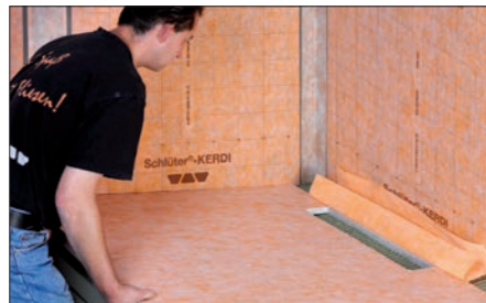
12 Ohne die Rinne anzuheben das Gefälleboard unter den Rand des Rinnenkörpers schieben.
